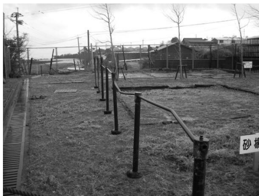
熱で鉄棒が曲がっている。
